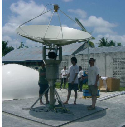
▲ L'antenne de Bitung, Indonésie, en cours d'installation. Antenna being installed in Bitung, Indonesia.
